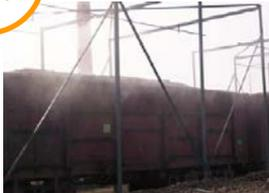
石炭同士の衝突により発生する粉塵に粗目のミストを散布。湿気を持たせることで粉塵浮遊を抑制し、**近隣への浮遊と粉塵爆発のリスクを回避**します。
