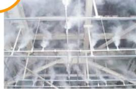
夏場にガスタービンに流入する吸気をミストで冷却することで、発電出力がアップし、**燃料の使用量を削減**できます。
