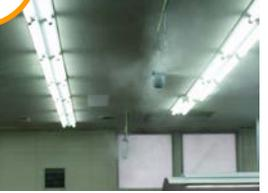
印刷工場内の加湿により、紙の印刷適性向上や静電気による紙粉防止、紙の反りや丁合ムラ防止など多く効果をもたらします。**印刷不良削減と環境改善。**
