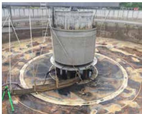
Die Grundräumer in den Nachklärbecken werden mittels Schwerlasträdern permanent über den Boden gezogen, um auf den Grund gesunkene Rückstände zur Mitte des Beckens hin abzutransportieren.
